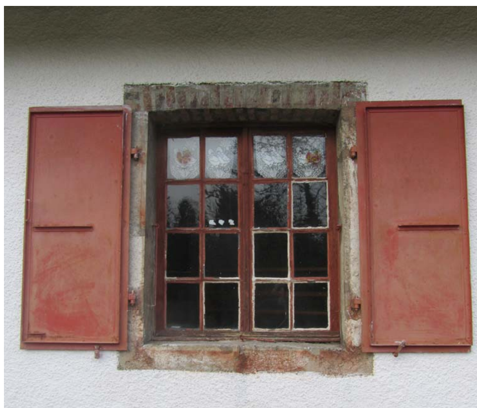
On a eu l'excellente idée de garder les anciennes fenêtres. Ici à 16 carreaux. C'est superbe.
