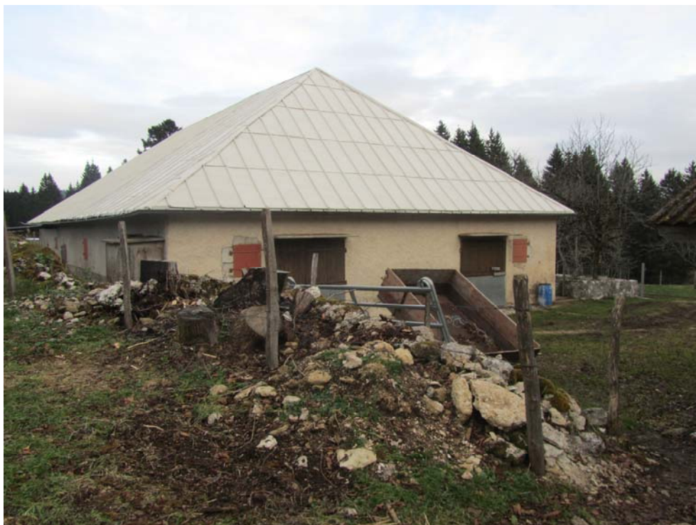
Façade ouest, la plus ingrate.
